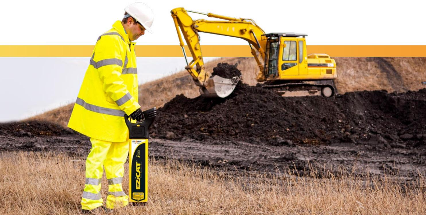
Chaque année, de nombreux ouvriers ont des accidents sur les chantiers et des équipements sont endommagés en heurtant accidentellement des câbles et tuyaux souterrains. Comme les réseaux souterrains deviennent de plus en plus complexes, il est très important de détecter leur emplacement avant d'entreprendre tout travail d'excavation.
